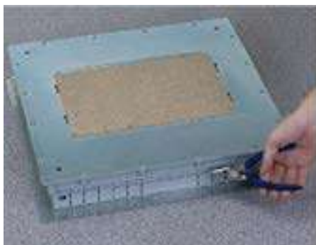
1 Recortar las entradas de canal
