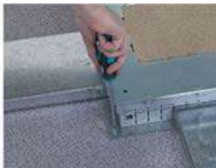
2 Introducir los canales y atornillar al suelo
