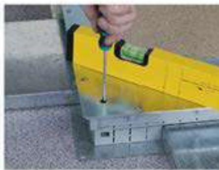
4 Nivelar con los torillos
